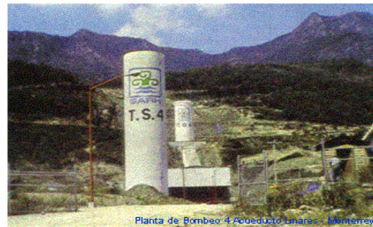
Planta de Bombeo 4 Acueducto Linares - Monterrey
